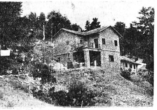
Αριστέρα εικόνηζείται τό κτίριον τής θερμής κατασκευής...
