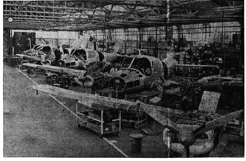
Είς τήν φωτογραφίαν διάφορα στάδια της κατασκευής τού Βρετανικού αεροσκάφους Μπήγκλ Β206Σ 'τό οποίον άπετέλει ένα από τά έκθέματα της Διεθνούς Έκθεσης 'Αεροναυ- τιών έγινε τελευταίως είς τό Παριτικόν και Διεσ'ήματός η οποίαίσι. 'Εξ γνωστών η άγγλική α- εροναυτια διακρίνεται διά τήν ποιότητά της.
