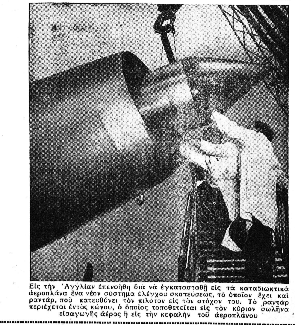
Εἰς τὴν Ἀγγλίαν ἐπινοήθη διὰ τὴν ἀεροπορικὴν ἀεροπλάνων ἕνα νέον σύστημα ἐλέγχου σκοπεύσεως, τὸ ὁποῖον ἔχει καὶ ραντάρ, ποὺ ἀνακρίβει τὸν πιλότον εἰς τὸν στόνον του. Τὸ ραντάρ περιέχεται ἐντὸς κώνου, ὁ ὁποῖος τοποθετεῖται εἰς τὸν κύριον σπλῆνα εἰσαγωγῆς ἀέρος ἢ εἰς τὴν κεφαλὴν τοῦ ἀεροπλάνου.
