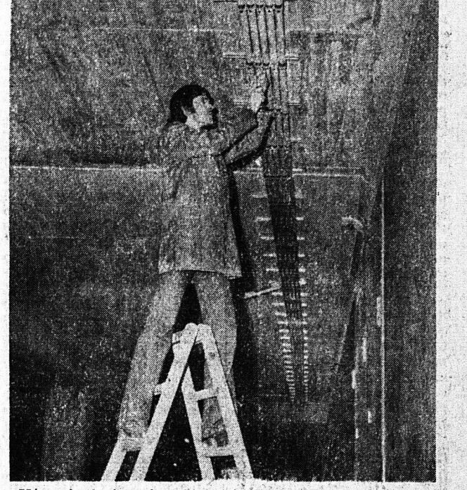
Μία ο' αυτών τους σωλητές από συνθετικό υλικό που στερεώνεται με ειδικούς βύθους για τη λειτουργία ενός νέου σταθμού του υδροσίου οδοδρομίου στο Μοναχό.
