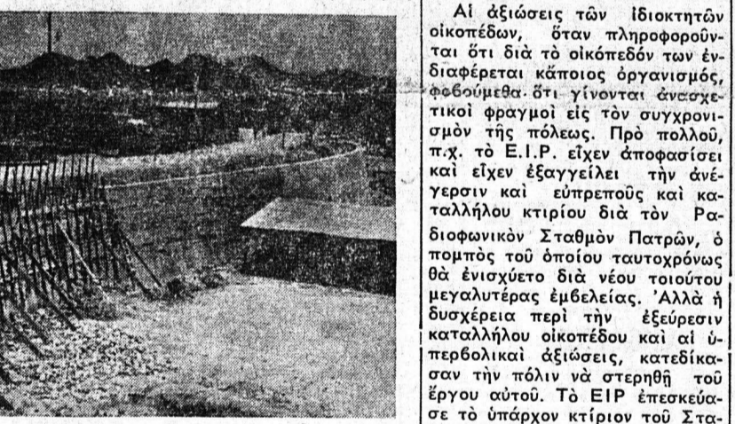
Τό εκτελούμενον εις Ζαβλάνι έργο — τοίχος άντισεισθή- Λαδικού, προς Κορίνθα
